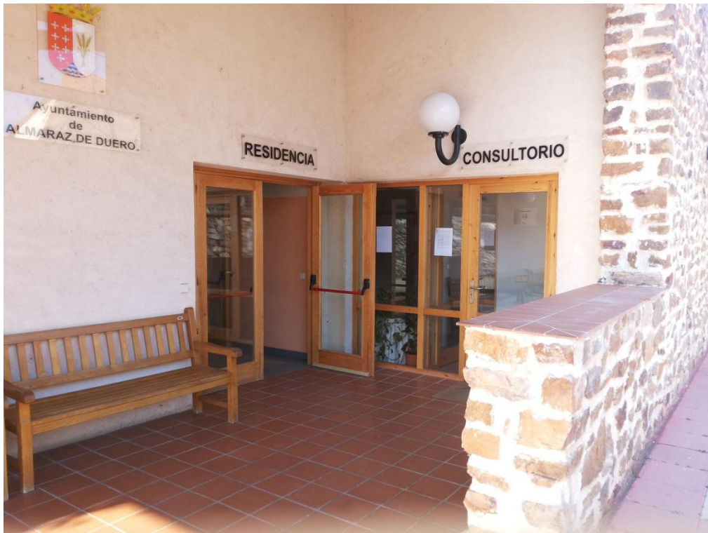
Entrada principal a la Residencia y al Consultorio Médico
